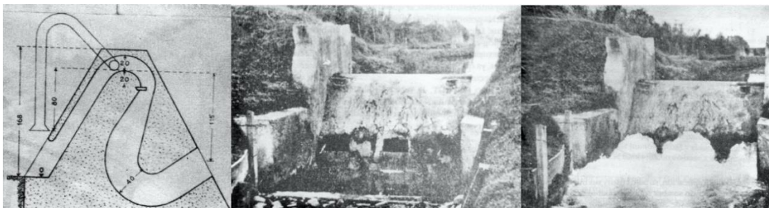
Plano de sifón antilarvario y en funcionamiento en Famaillá, Tucumán, 1942
