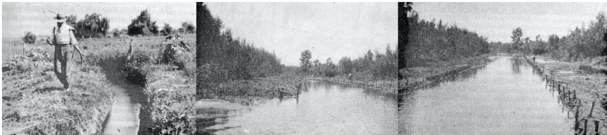
Empetrolado de una acequia (1927) y rectificación de curso de agua, antes y después, Ledesma, Jujuy (1938)
